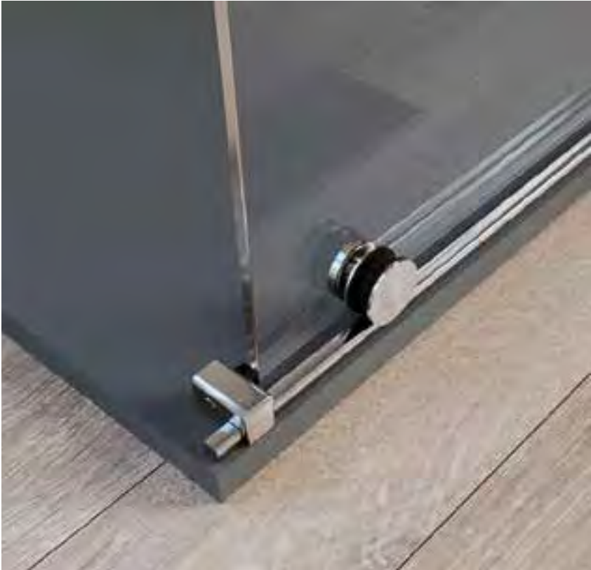
Detalle rodamiento y tope inferior.
